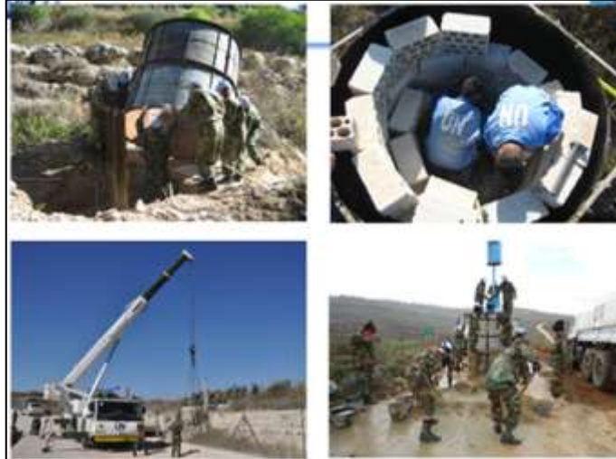
Photographies des étapes de construction d'un Blue Barrel (sources internes FINUL).
