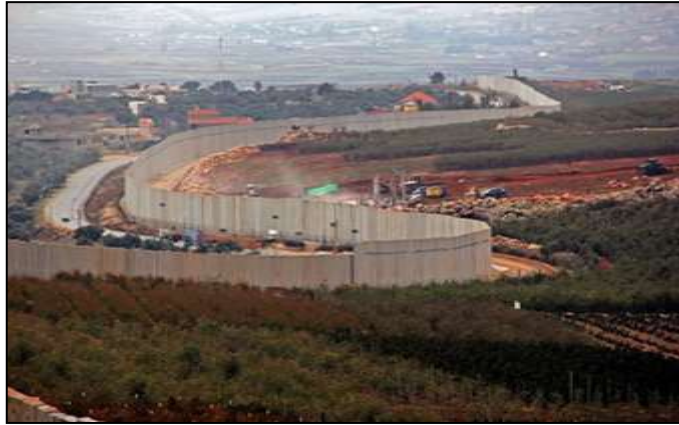
Exemple de construction du mur dans la région de TP 36 (El Adeisse) (sources internes FINUL).
