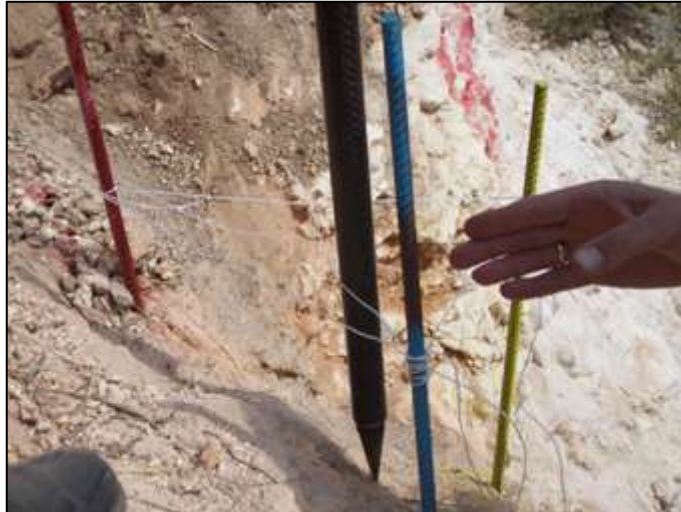
Photographie du processus de précision de l'emplacement d'un futur « blue barrel » (sources internes FINUL).
